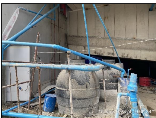
ภาพที่ 19 ถังบำบัดน้ำเสียสำเร็จรูป
